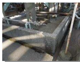
【川崎工場 防液堤】
