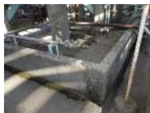
【川崎工場 防液堤】
