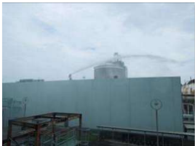
【遠隔放水銃訓練の様子】
