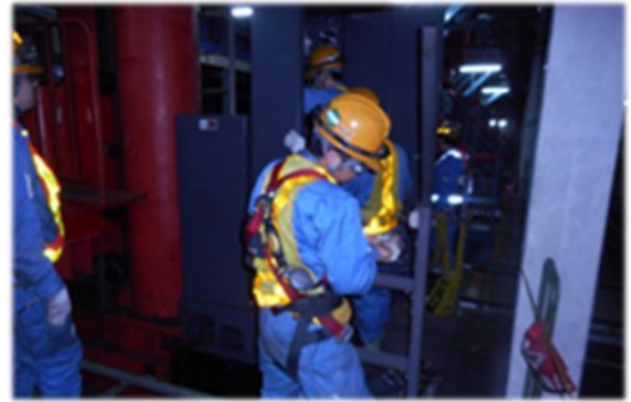
【川崎工場の立体倉庫の月次点検作業時における墜落制止用器具(フルハーネス)の着用の様子】
